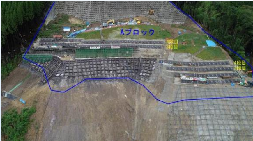
滑落崖の整形と法枠工設置，Aブロックでアンカー工3段，Bブロック4段施工（令和元年7月終了）
