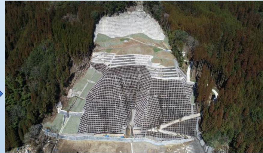
地すべり斜面下部の法枠工完了（令和2年）
