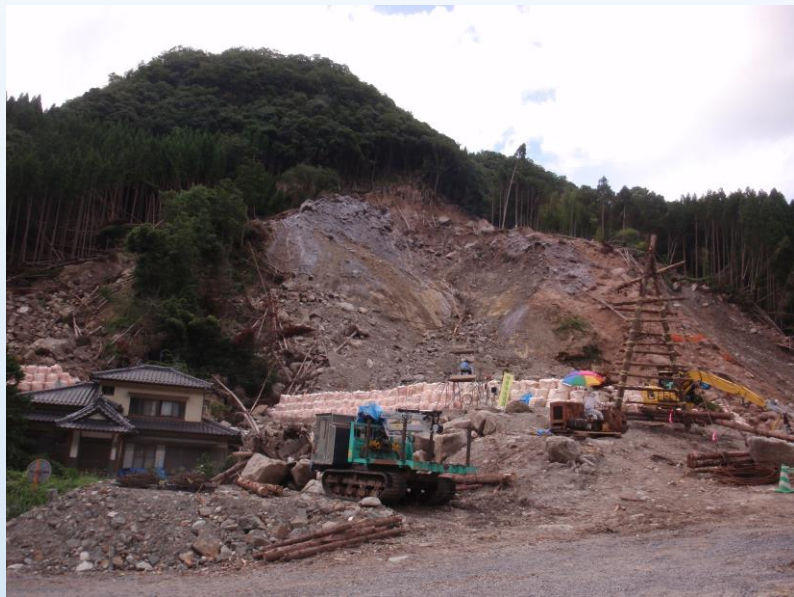
下端から見る全景
