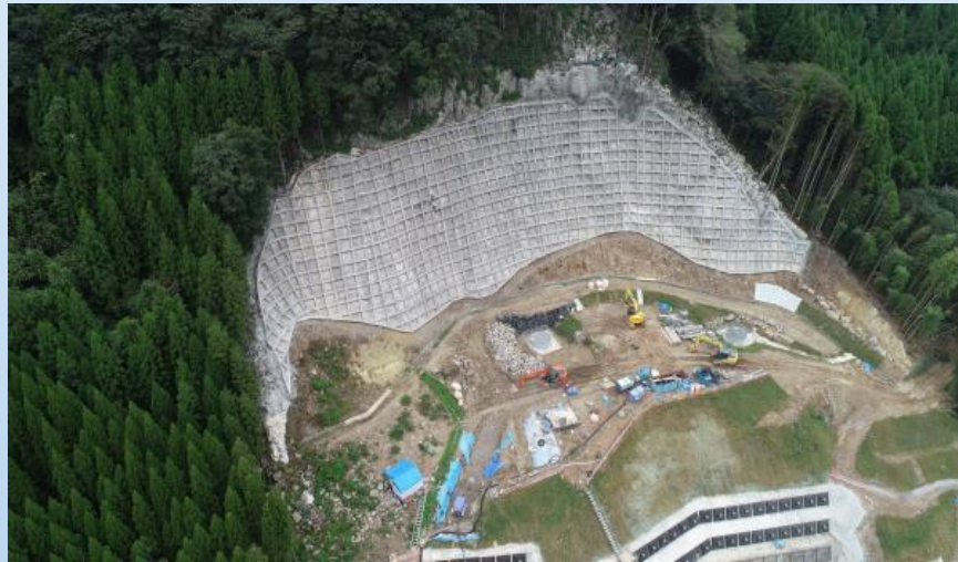
Aブロック内の集水井2基施工（令和元年12月終了）
