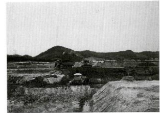
右岸池敷掘削
