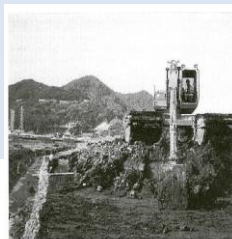
左岸池敷掘削（水陸両用掘削機）
