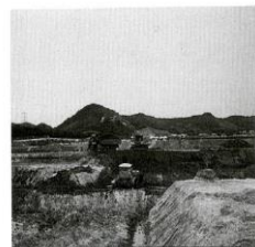
右岸池敷掘削
