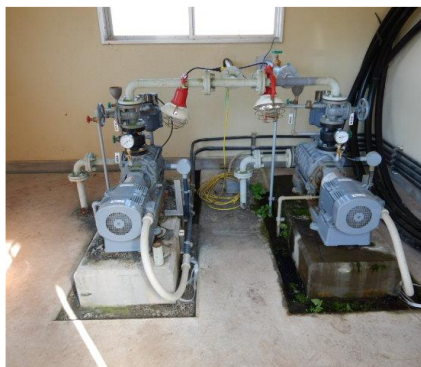
揚水機場・加圧機場
