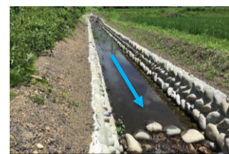
写真-3 練石積水路(施工後)
