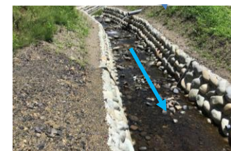
写真-4 落差工(施工後)
