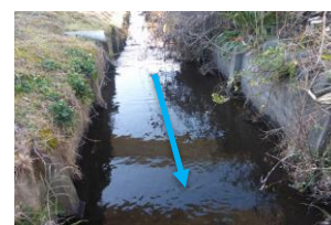
写真-2 プレハブ水路(現況)
