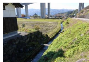
写真-1 現況の水路周辺
