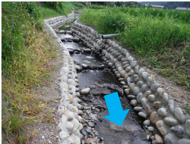
改修後の状況
