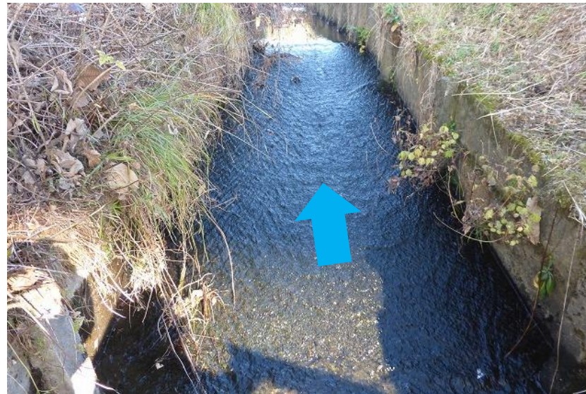
水路底の状況
